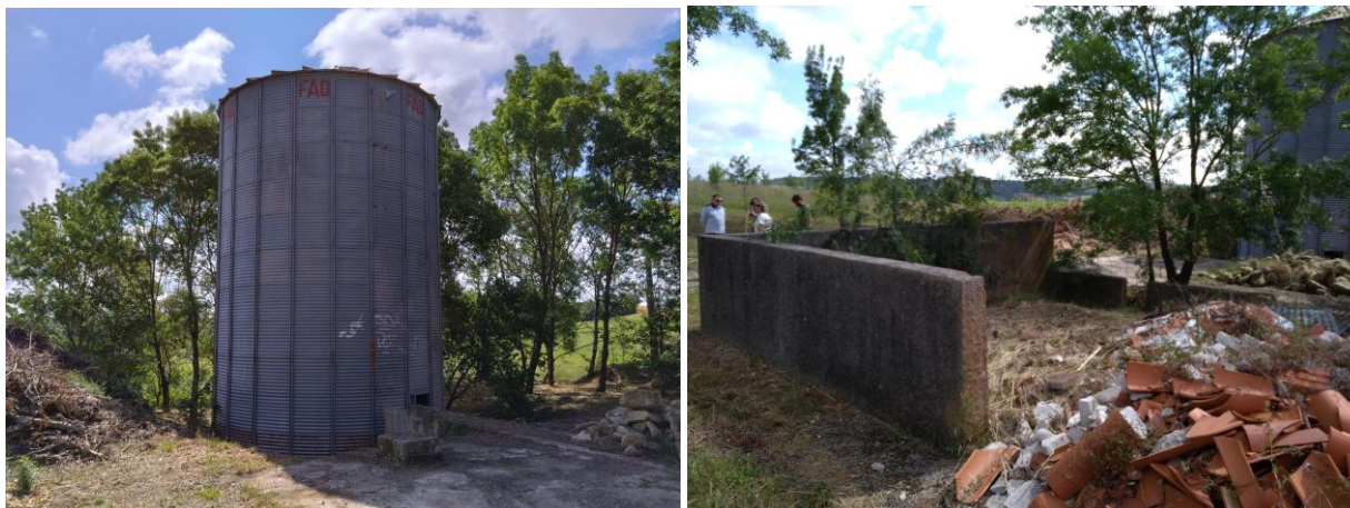
Le silo existant (photo 1) devant être démoli, et la dalle bétonnée (photo 2) sur laquelle s'appuiera le bâtiment de stockage.
